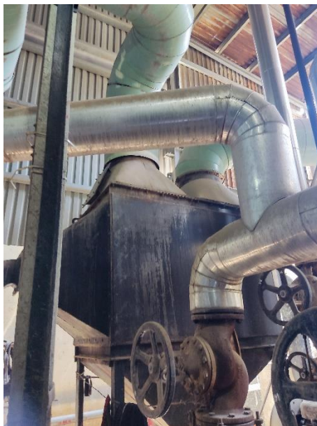
Hình 3. 7. Cấu tạo thiết bị Cyclone chùm của HTXL khí thải lò hơi
