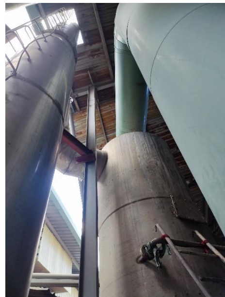
Hình 3. 7. Cấu tạo thiết bị Cyclone chùm của HTXL khí thải lò hơi
