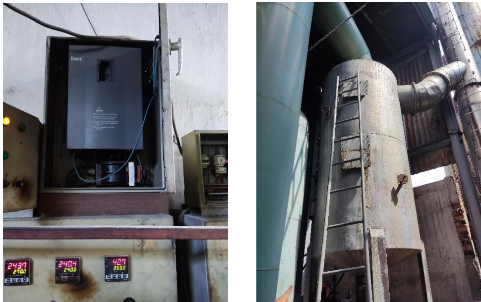
Hình 3. 10. Cấu tạo thiết bị tách lọc ướt của HTXL khí thải lò dầu tải nhiệt
