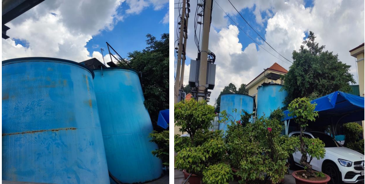
Hình 3. 5. Hình ảnh HTXL nước thải sản xuất công suất 150 m 3 /ngày của cơ sở
